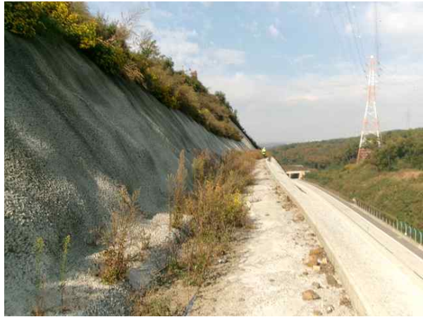
1소단 배수로 전경
